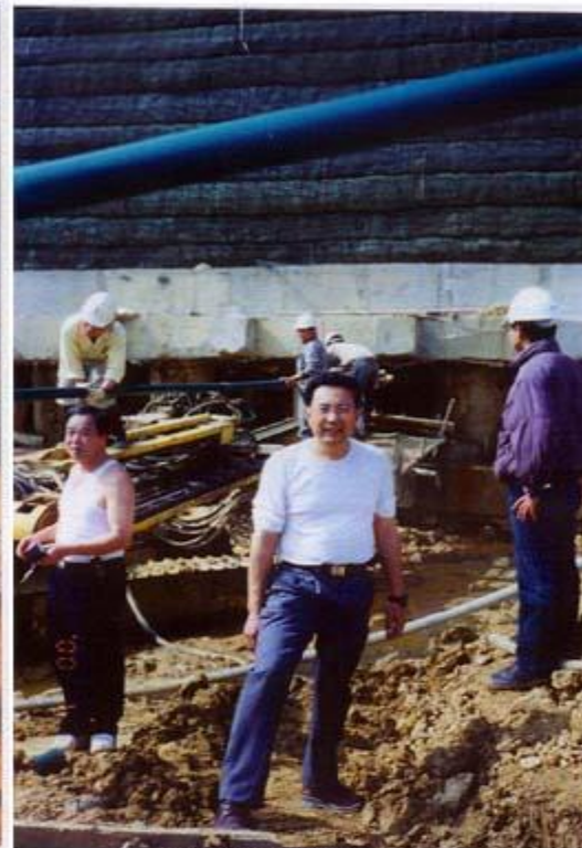
DRILLING OPERATION 底部钻孔作业
